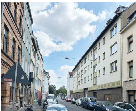
Gereonswall vor Neuausbau und Fassadenerneuerung im September 2024
