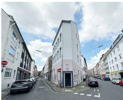
Probsteigasse (rechts Gereonswall) vor Neuausbau und Fassadenerneuerung im September 2024
