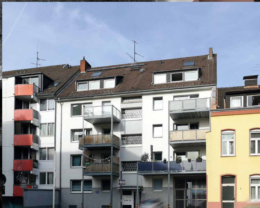
NORDSTRASSE 53-55 IM OKTOBER 2022 VOR NEUAUSBAU
